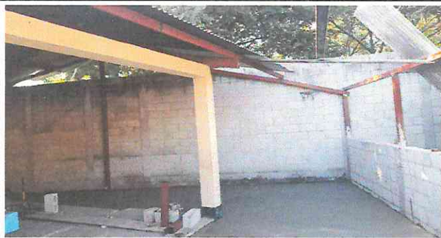
Foto 1: MÓDULO 1. Remozamiento de muro de cocina y cimiento corrido, con cinco hiladas de block.
