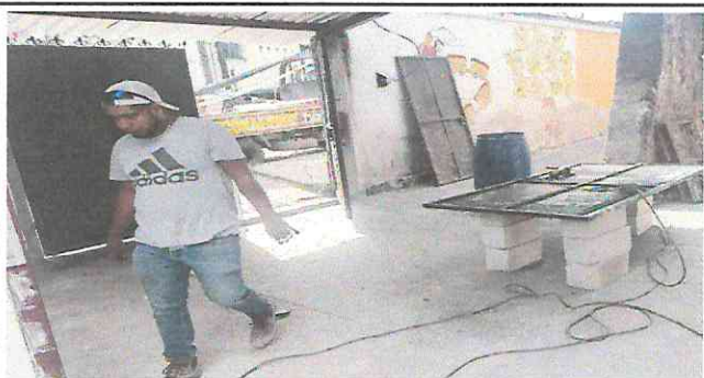
Foto 5: MÓDULO 4. Remozamiento de portón.
