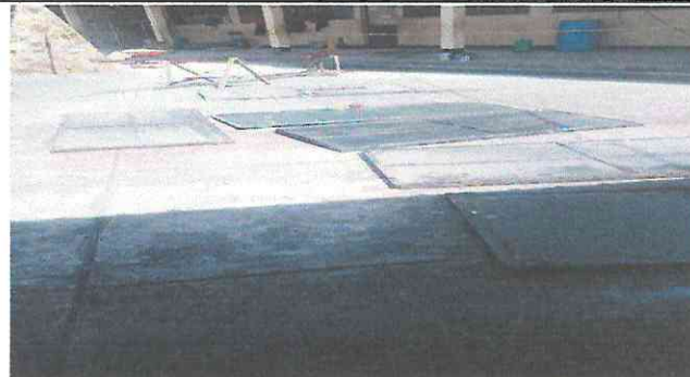
Foto 2: MÓDULO 2. Remozamiento de puertas en aulas.
