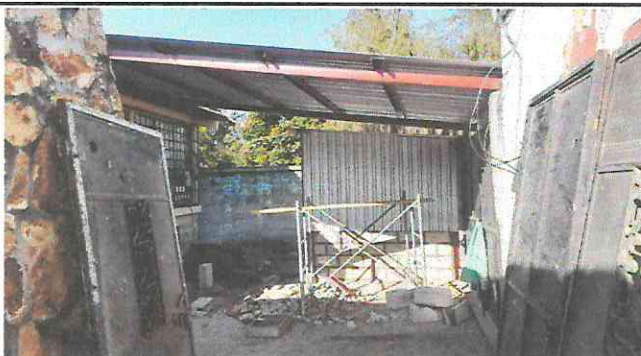
Foto 3: MÓDULO 3. Remozamiento de paredes con hiladas de block en basurero.
