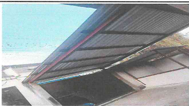
Foto 4: MÓDULO 4. Sustitución de lona por techo de lámina.
